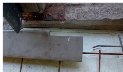
Bild 3. Skärning av tröskelns ändra för korrekt placering i förhållande till dörrtätningen.
